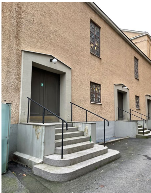
Sidan av Lorensbergsteatern och stråket mellan Lorensbergsteatern och parkeringsgaraget från Berzeliigatan.
